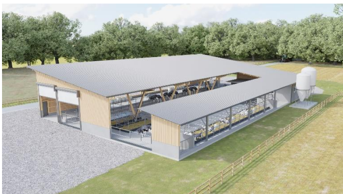
Bild 1: Aussenansicht des schlüsselfertigen Normstalls VMS für 45 Kühe
