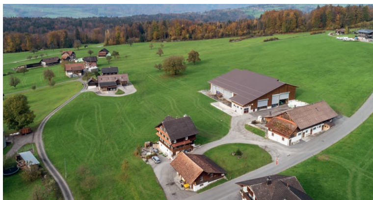
Cette nouvelle construction se fond bien dans le paysage. La nouvelle étable DeLaval, dotée d'une grange, se distingue par ses bonnes fonctionnalités, sa structure ainsi que les faibles coûts de construction.
