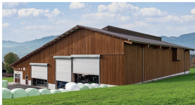
L'étable DeLaval comporte de nombreux détails sophistiqués. Par exemple, les séchoirs en grange se trouvent en dessous du toit. C'est une économie de place, et l'air préchauffé (récupération de la chaleur du soleil) sèche le foin plus vite.
