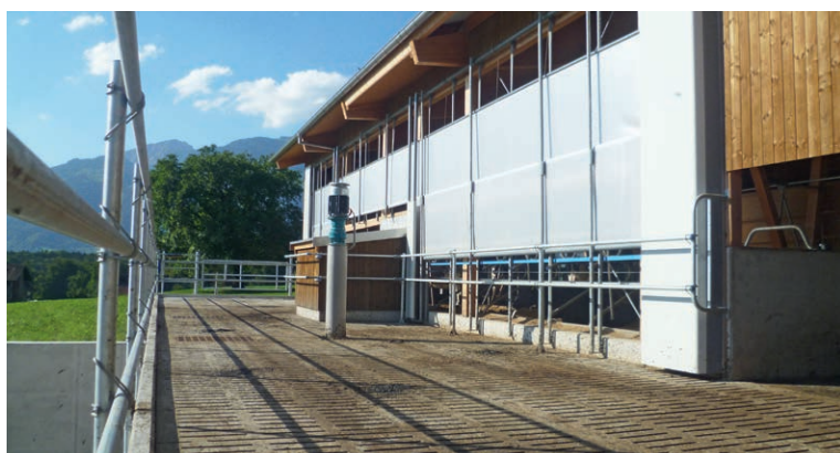
La face sud du bâtiment peut être ouverte de haut en bas. Le rideau brise-vent blanc transparent sert à aérer, éclairer et ombrager l'étable.
