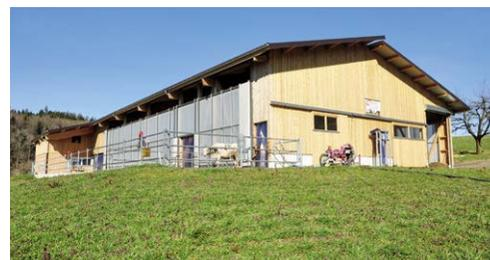
Vue de la façade équipée de systèmes de portes à enroulement coupe-vent
