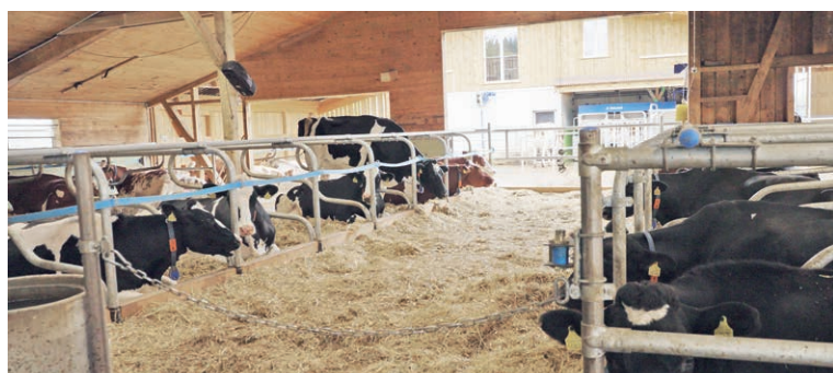
Les logettes ont été intégrées au bâtiment existant. Le robot, visible à l'arrière-plan, est installé dans le nouveau bâtiment.
