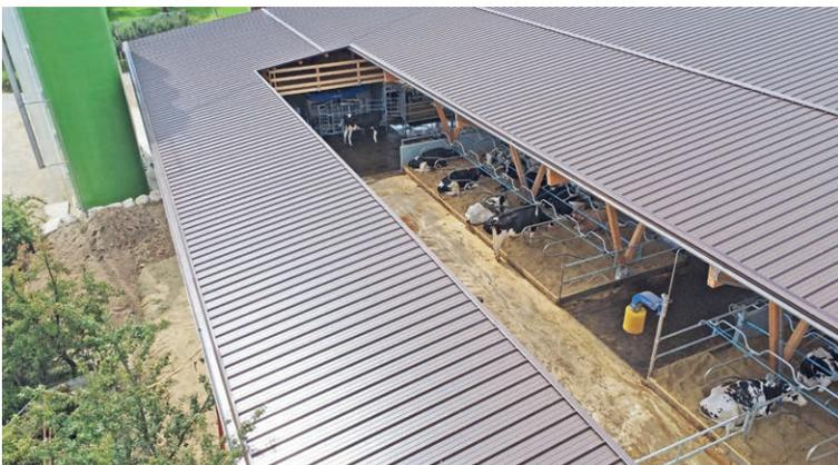
La taille et la découpe du toit sont adaptées au nombre de vaches et à la grandeur de la cour. Le toit pourrait aussi être complètement fermé par la suite.
