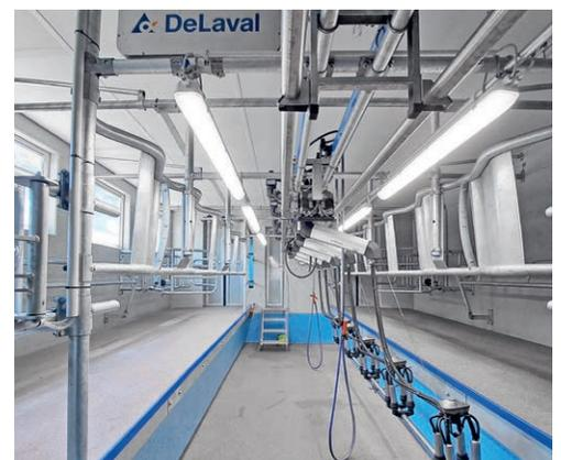
DeLaval a réalisé les travaux d'architecture et fourni l'entier de l'équipement de ferme pour le projet de la famille Crottaz. La salle de traite en épi 50° 2x5 Midiline est équipée d'un décrochage automatique et permet de réaliser la traite et le nettoyage en 45 minutes.
