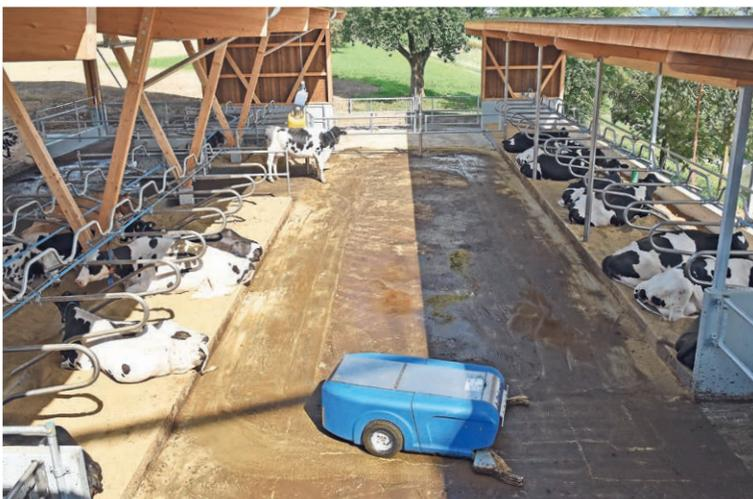
L'espace menant à la sortie sert à la fois de couloir et de zone d'attente devant le robot de traite. La place d'alimentation et la cour ont été réalisées en une seule dalle en béton, ce qui a permis d'économiser des frais de maître d'œuvre. Le robot racleur nettoie toutes les surfaces.
