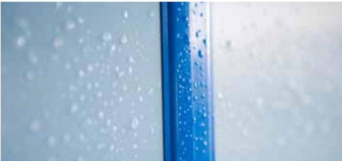
Les panneaux PVC DeLaval sont fabriqués à 100 % en PVC de haute qualité. Ils sont disponibles en deux tailles et en deux couleurs. Ces panneaux résistent aux détergents acides et alcalins utilisés sur les fermes. La surface lisse empêche le développement des bactéries ou des germes. Les murs sont lavables et résistent bien aux nettoyeurs haute pression.
