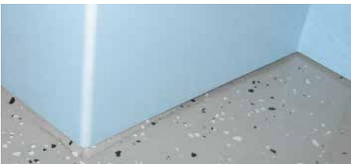
Les panneaux sont suffisamment solides pour plier les coins et les bords. Sans bords ni profilés d'angle, le montage est simplifié et il est généralement plus facile à nettoyer.
