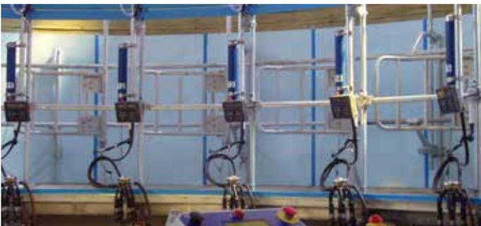
Les panneaux PVC résistent aux chocs causés par les animaux et les outils. Vous avez le choix entre les panneaux de couleurs bleue ou blanche, avec une gamme complète d'accessoires : profils d'angle, couvre-joints et plinthes. Ces panneaux se posent facilement au moyen d'une colle spéciale et/ou de vis coordonnées à la couleur des panneaux.
