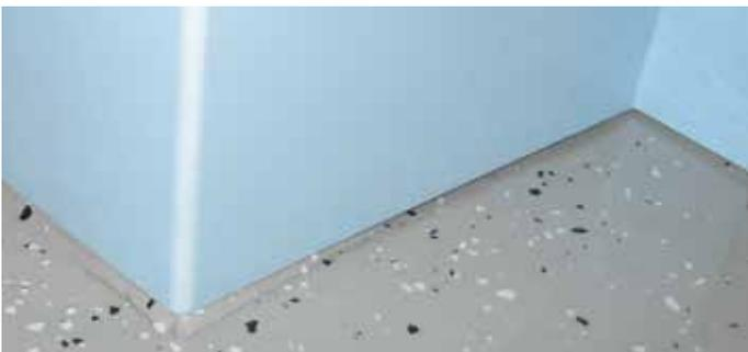
Die Platten sind stark genug für den Umbau bei Ecken und Kanten. Ohne Kanten- und Eckprofile wird die Montage vereinfacht und es ist allgemein besser zu reinigen.
