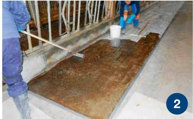
Alle DeLaval Plast™ Boden- und Wandbeschichtungen beginnen mit der Beschichtung der Grundierung. Diese wird einfach mit einer Rolle auf die trockene und saubere Oberfläche aufgetragen.
