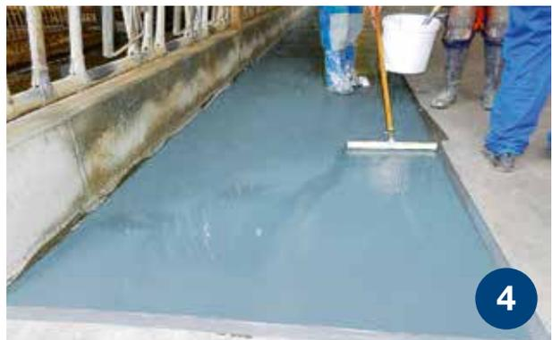
Die Versiegelung gibt der Beschichtung den finalen Schutz für eine langlebige und leicht zu reinigende Oberfläche.
