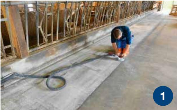
Vor dem Auftragen jeder Oberflächenbeschichtung müssen alle Untergründe gut vorbereitet werden. Nur so kann eine ausgezeichnete Haftung und damit eine hochwertige Qualität gewährleistet werden.
