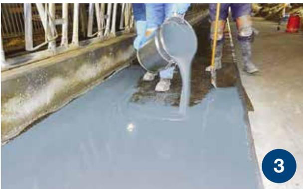
Um einen glatten Futtertisch zu erhalten, wird anschließend ein Gemisch aus DeLaval Plast™ Beschichtung und einem hochwertigen Quarzsand aufgetragen. An den Wänden wird die DeLaval Plast™ Wandfarbe benutzt.
