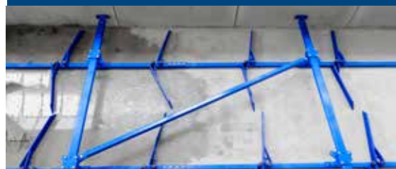
Stabiliseringsbyglar var 20e meter
