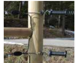
Bilde 15. Bruk gripper , 86674702 når du skjøter.
