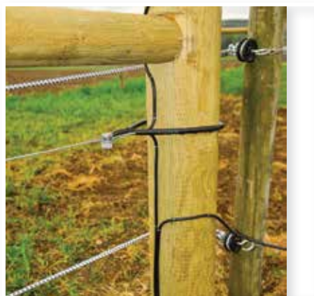
Bilde 22. Tråd kobles med strømkabel og trådskjøt.
