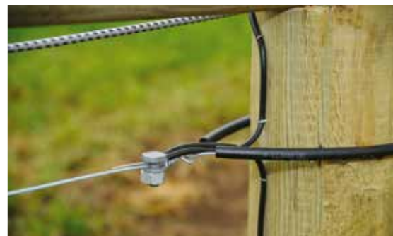
Bilde 22. Sikker trådkobling fra apparat til gjerde.
