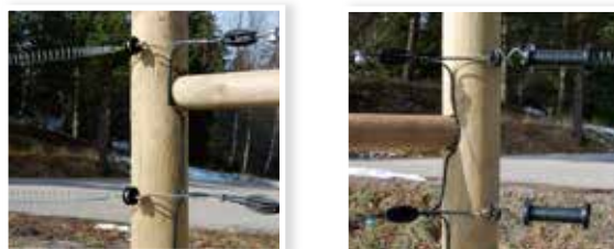
Bilde 16 og 17. Montering av fjærgrind.
