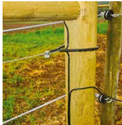
Bilde 21. Tråd kobles med strømkabel og trådkjøt.
