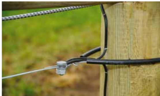
Bilde 23. Sikker trådkobling fra apparat til gjerde.
