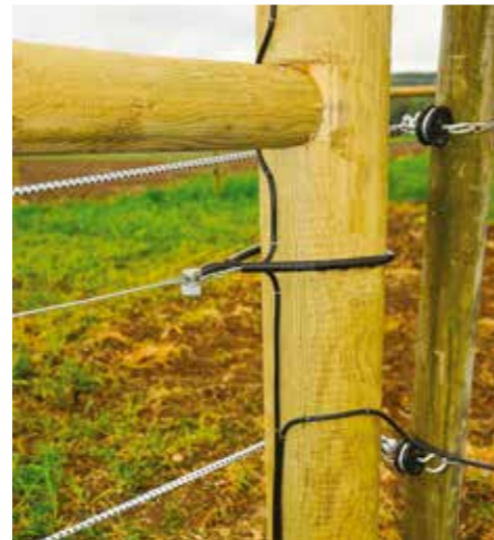
Bilde 22. Tråd kobles med strømkabel og trådsjøt.
