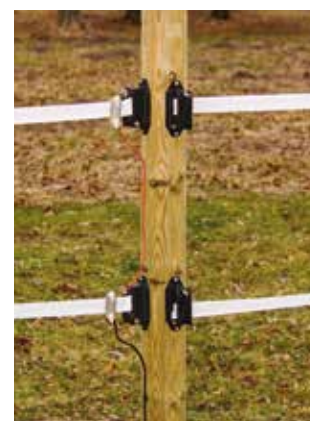
Bilde 10a og 10b. Grav ned den strømførende ledningen og koble slik at grinden blir strømløs når den åpnes (strømmen går isteden via den strømførende ledningen).
