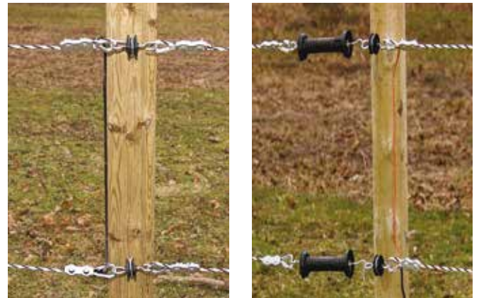
Bilde 9 og 10. Koble strømforsyningskabel slik at grinden blir strømløs når den åpnes (strømmen går isteden via jord- og veggkabel).
