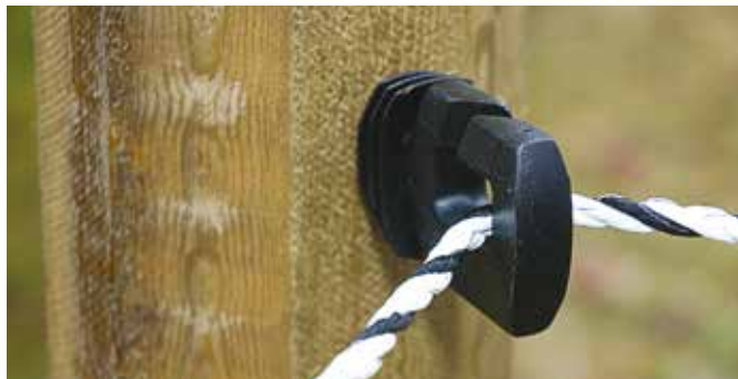
Bilde 4. Isolatorene settes diagonalt på stolpen i hjørnet.
