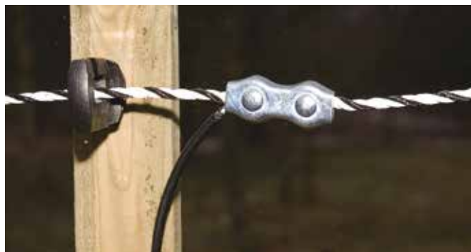
Bilde 13. Sikker trådskjøt fra apparat til gjerde.
