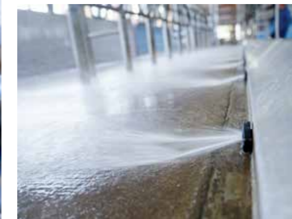
Platform spuledyser for en ren arbejdsplads
