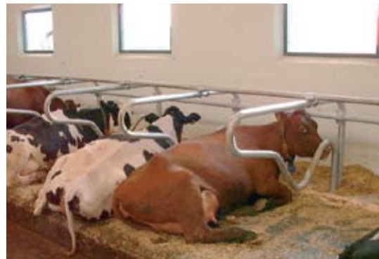
DeLaval liggebås CC1800 for enkelrad. Det store friarealet foran kua gir rom for naturlige reise- og leggebevegelser.
