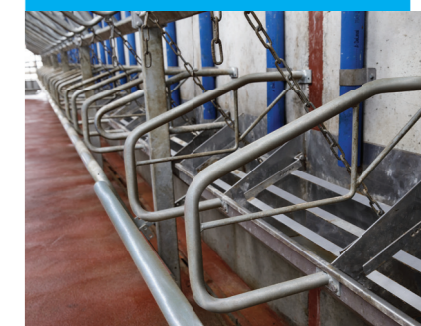
Alimentation en salle de traite
