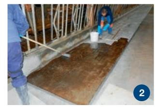
Tous les sols et murs DeLaval Plast™ sont enduits d'un primer appliqué sur une surface sèche et propre. Facile à appliquer avec un rouleau ou une raclette
