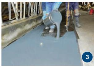
3. Pour obtenir une table d'alimentation régulière, le primer est suivi par un mélange de revêtement DeLaval Plast™ et un sable de quartz de haute qualité. Pour les murs, une couche de couleur DeLaval Plast™ est appliquée au rouleau.
