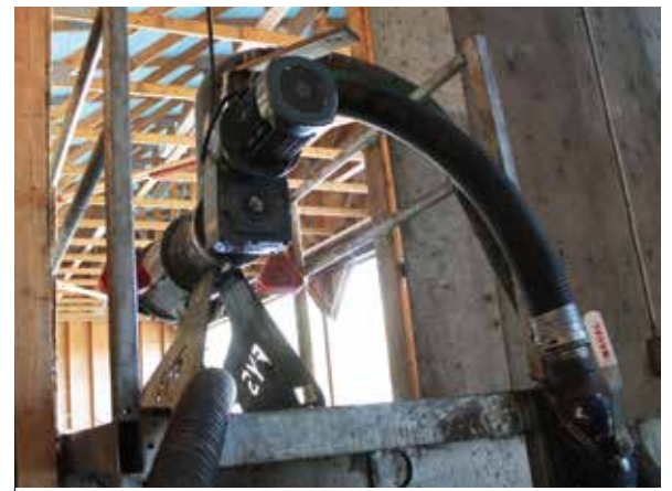
Nestemäinen jae johdetaan separaattorilta suoraan lietesäiliöön. Sen sijaan kuiva-aine putoaa separaattorilta lantalaan. Tätä jaetta käytämme ja uudelleen kierrätämme nuorkarjan kuivituksessa levittämällä sitä kestokuivikepohjaan.
