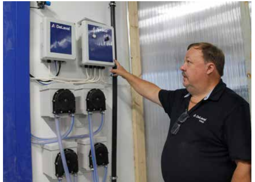
Automaattinen sorkkakylpy DeLaval AFB1000 on verraton apu sorkkaterveyden ylläpidossa. Sen avulla sorkkakyllyn teho on mahdollista pitää jatkuvasti yllä.
