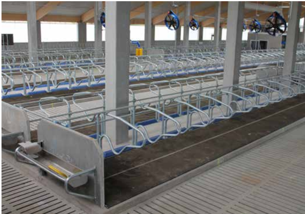
Eläinystävällinen, 6-rivinen pihatto, jossa DeLaval CC1800 -makuuparret DeLaval ST200 -juoma-altaat sekä DeLaval SCB -karjarahja. Teräksiset, kipattavat juoma-altaat on helppo pitää puhtaina ja käytävät on suunniteltu leveiksi, jolloin lehmillä on hyvin tilaa liikkua.
