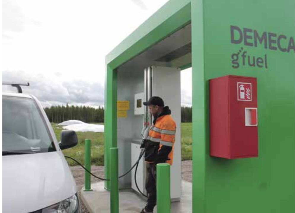
Biometaania tankataan myös tilan omaan pakettiautoon. Kuorma-autolle on oma tankkauspistoolinsa.
