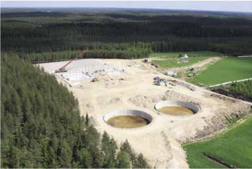
Kuva projektin alkuvaiheilta.
