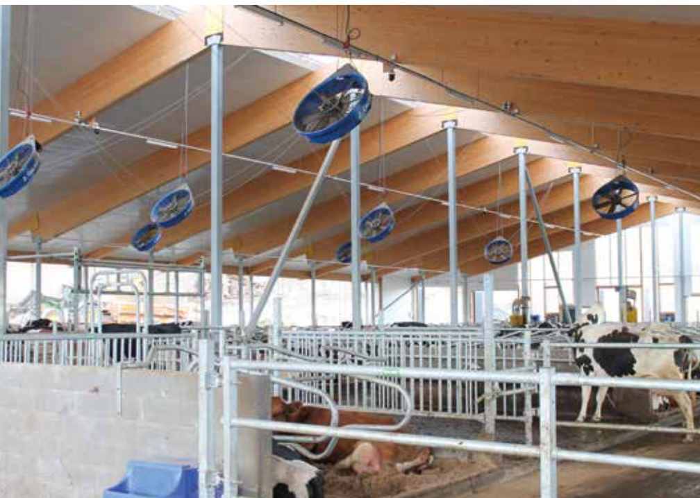
Navetan ja lehmien viilennys tapahtuu 10:llä DDF1200P viilennyspuhaltimella.
