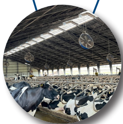
Jahutusventilaator latrite kohal
