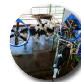
Staldventilatorer over opsamlingspladser ved malkebotter
