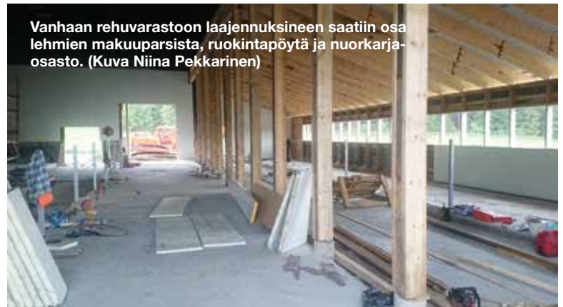
Vanhan parsinavetan yhteydessä olevaa rehuvastoa levennettiin 7 m. Muutoin uusi robottipihatto tehtiin olemassa olevien seinien sisälle. (Kuva Niina Pekkarinen)
