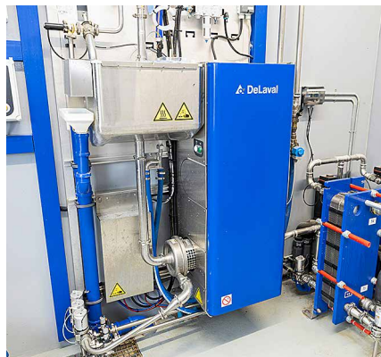
Um die bis zu 200 m langen Milchdruckleitungen reinigen zu können, entwickelte DeLaval den Automaten Q-Cleaner.
