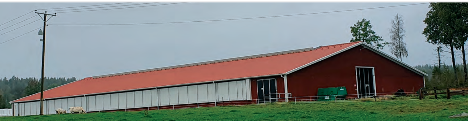
Stallet för 270 djur sett från utsidan.
