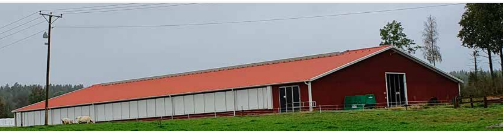
Stallet för 270 djur sett från utsidan.
