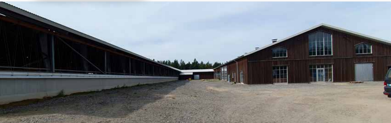
Till vänster syns ligghallen för djuren och till höger mjölkningsplatsen med en DeLaval roterande mjölkningsstall E300 med 40 platser.
