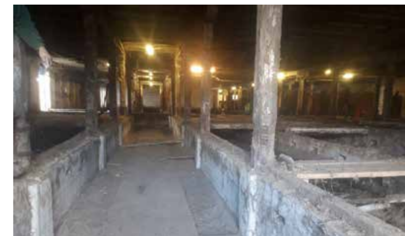
Stallet under rivningsprocessen.
