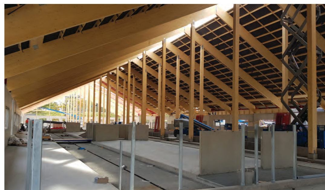
Stommen av limträbalkar ger ett imponerande och vackert intryck. Stor vikt har lagts på exteriören och djurvälståndet vid planeringen av stallet.
