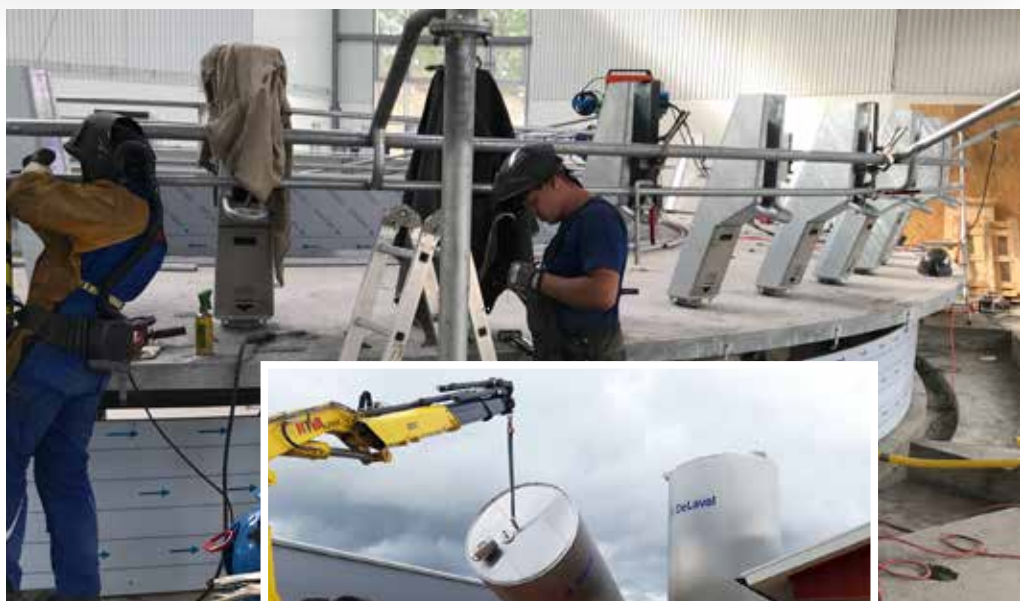
Montage av den utvändiga karusellen
