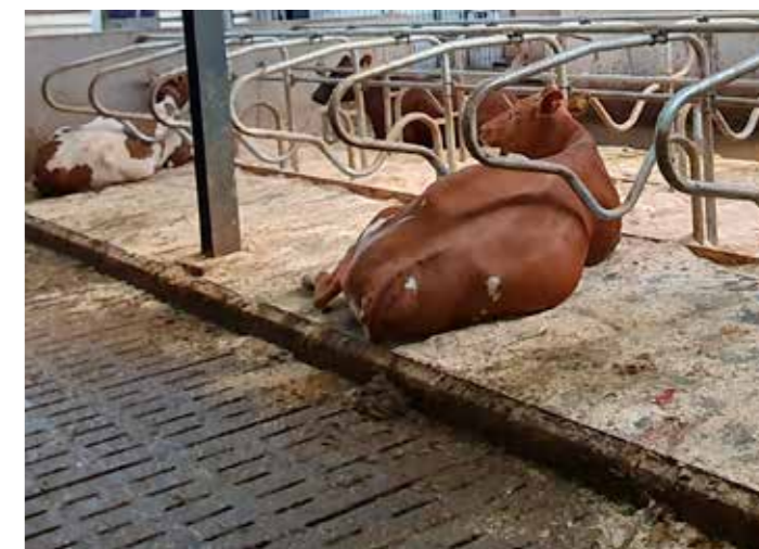
Gödselroboten håller spalt och liggbåskanterna rena vilket ger bra klöv- och juverhälsa utan manuellt arbete.
