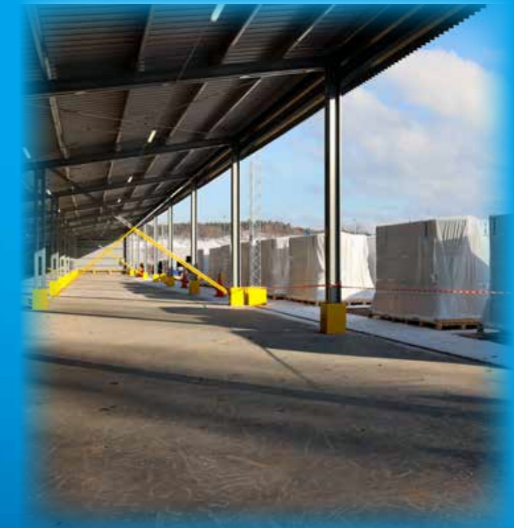
Utanför fabriken finns nu ett nytt skydd för färdigproducerade mjölkkningsrobotar som väntar på att bli levererade ut till kunder. När bilden togs hade VMSerna inte fått flytta in ännu.
