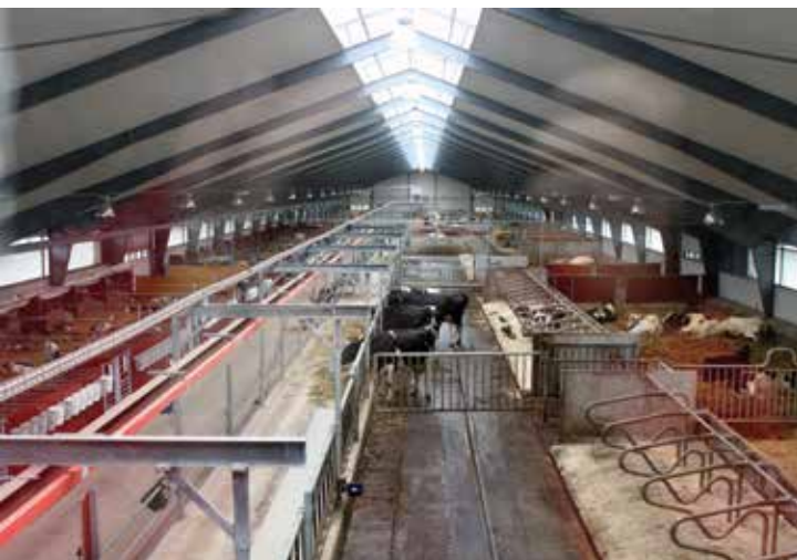
Kalvnings- och kalvstallet har stora ströbäddar där dräktiga kor väntar på att kalva och 12 separata kalvningsboxar på höger sida och gruppboxar för kalvar på vänster sida.
