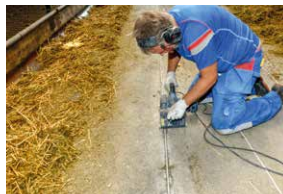
Ulrik Elmersson från DeLaval fräser urspårningen där induktionslinan ska gå.
