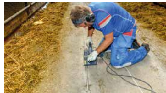
Ulrik Elmersson från DeLaval fräser urspårningen där induktionslinan ska gå.
