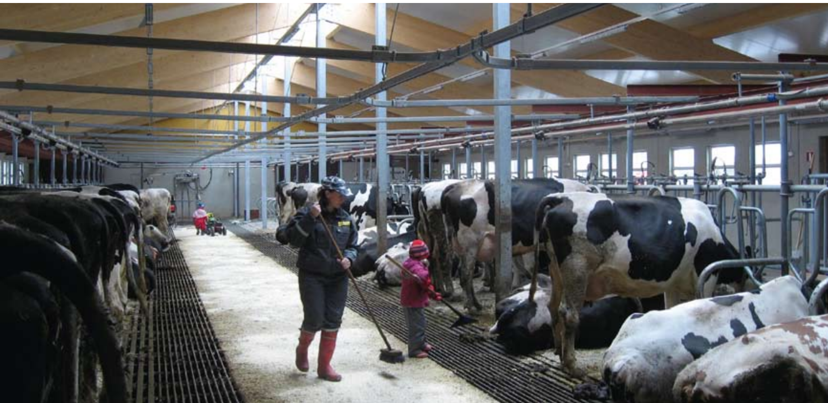
Ilmanvaihto on toteutettu harjalla olevien avattavien luukkujen ja automaattisesti säätyvien seinäluukkujen avulla. Valoa läpäisevä harja antaa runsaasti luonnonvaloa navettaan ja liimapuupalkein toteutettu rakenne avaruutta ja ilmapuutta rakennukseen.
