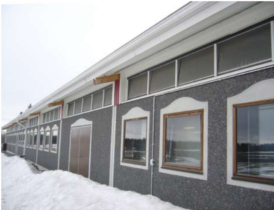
Kuvassa tuloilmaluukut, jotka päästävät tuloilman lisäksi runsaasti valoa navetan sisälle. Niin eläimet kuin hoitajatkin viihtyvät hyvin valoisassa navetassa.
