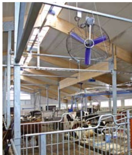
Uusi navetta on erittäin valoisa. Valoisuus perustuu paljolti DeLaval harjaikkunoihin. Katon harja on peitetty niillä lähes koko mitaltaan. Myös hormien sadehatut ovat valoa läpäiseviä. Ilmanvaihtopaneelien valon läpäisevyys on peräti 98 prosenttia. Päätykolmioissakin on isot polykarbonaatti-ikkunat.
