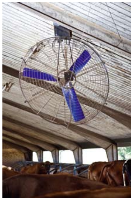
Lisälämmön tarvetta voidaan vähentää myös viilennyspuhaltimien avulla, jotka sijoitetaan talviaikana niin että ne puhaltavat ylöspäin karkaavaa lämmintä ilmaa takaisin alas, jolloin kosteus sitoutuu paremmin.
