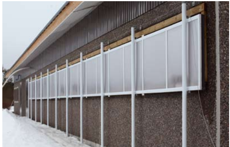
Navetan ilmanvaihto perustuu DeLaval VPT-ilmanvaihtopaneeleihin ja säätöluukuilla varustettuihin DeLaval C1 hormeihin. Ilmanvaihtopaneelit ovat kaksikerroksista Lexan –polykarbonaattilevyä, eli niiden välissä on eristeenä toimiva ilmakerros. Kumitiiviste sulkee aukon tiiviisti, jos sellainen tarve tulee.
