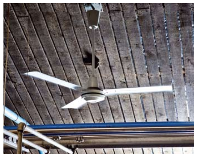
DeLaval kattopuhallin PF142 on suunniteltu lypsyasemakäyttöön ja eläintiloihin, vähentämään karpäsiä ja parantamaan työympäristöä. Puhaltimen maksimi kapasiteetti on 43400 m 3 /h.
