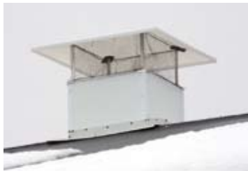
Navetan ilmanvaihto perustuu DeLaval VPT-ilmanvaihtopaneeleihin ja säätöluukuilla varustettuihin DeLaval C1 hormeihin. Ilmanvaihtopaneelit ovat kaksikerroksista Lexan –polykarbonaattilevyä, eli niiden välissä on eristeenä toimiva ilmakerros. Kumitiiviste sulkee aukon tiiviisti, jos sellainen tarve tulee.
