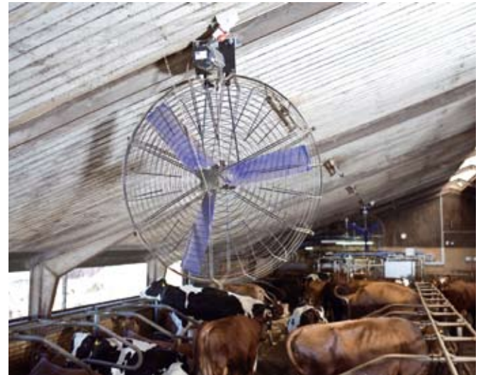
Halkaisijaltaan massiivisen, 130 cm DF1300-puhaltimen kapasiteetti on 48 500 m 3 /h ja vaikuttaa jopa 146 metrin päässä. Puhaltimen pyörimisnopeus on mahdollista saada säätämään sisälämpötilan mukaan.
