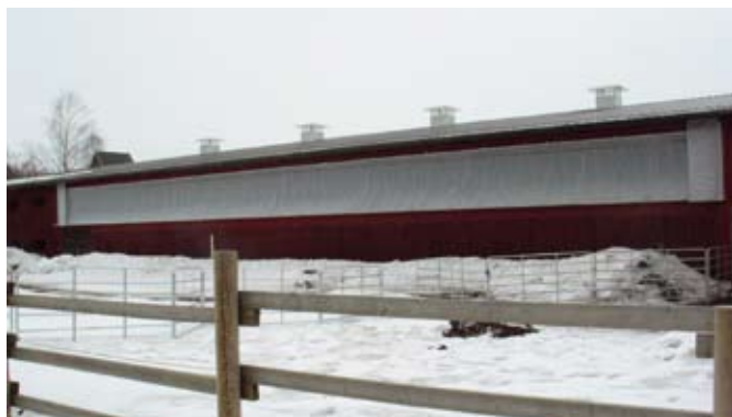
Ilmanvaihto hiehopihatossa on toteutettu viidellä C1-poistohormilla ja rullautuvilla CRAW-tuuliverhoilla.
