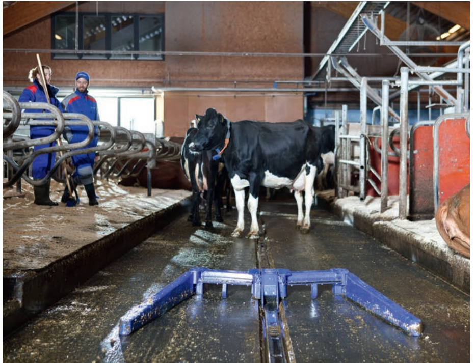
Hydraulinen ACH-kaavin puhdistaa tehokkaasti ja äänekkäästi lannan kouruista koska kaapimien alapinnassa on kumilista. Kaavin on muodoiltaan eläinystävällinen ja antaa paljon liikkumatilaa lehmille – häiritsemättä niitä.
