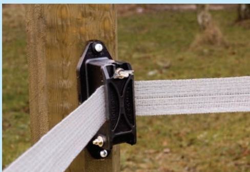
Isolatorerna sätts diagonalt på stolpen i hörnen.
