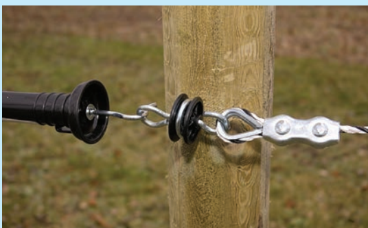
Grindhantag med trådskarv och kauser.
