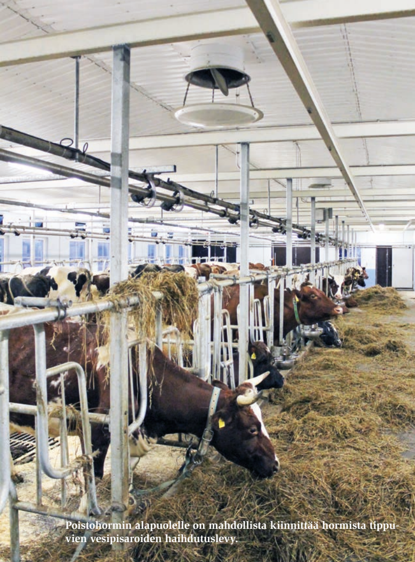
Uusissa DeLaval -tuloilmaluukuissa on erittäin varmatoiminen säätömekanismi.
