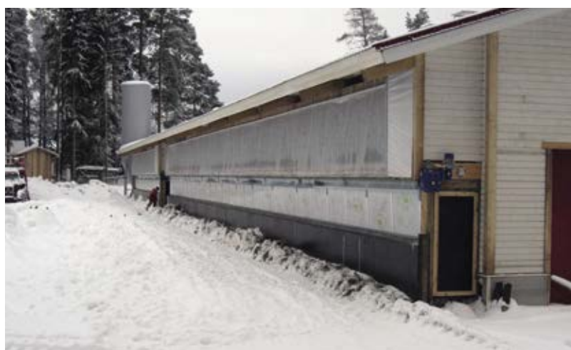
NAVETAN ULKOSEINÄLLÄ visiirin yläpuolella on laskostuva DeLaval verho, mikä kuvassa on täysin kiinni. Visiiriruokinnan etuna on, että rakennusalaa säästyy, mutta talvella pitää varautua lumitöihin ennen rehunjakoa.
